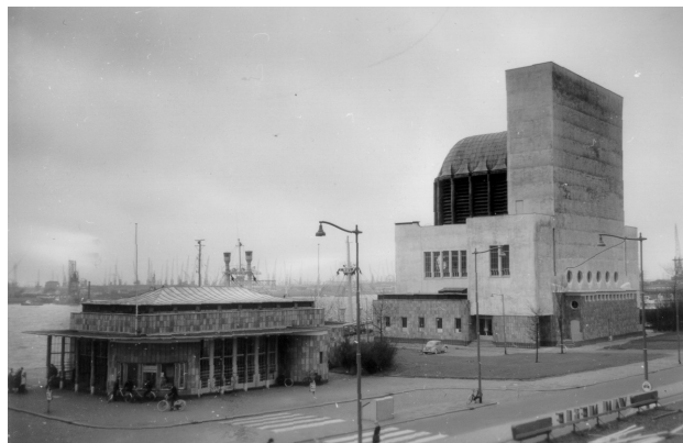
Rotterdam (Niederlande): Luftschachtgebäude des Maastunnels 1965 (Quelle: testimon Fotoarchiv)
