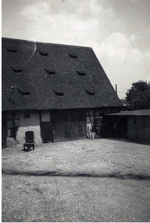
Scheune des Bauernhofes in der Rothenburger Straße 170
