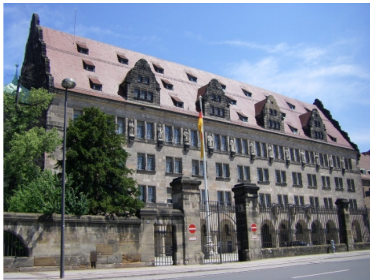
Justizgebäude an der Fürther Straße
