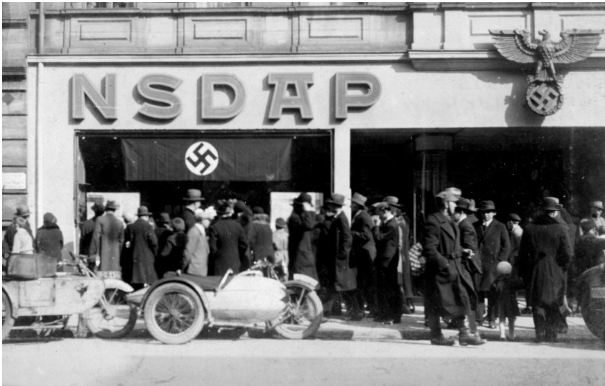
Die damalige Schaltzentrale der NSDAP in Fürth, das Braune Haus , Nürnberger Straße 7. Es wurde nach Treffern im Luftkrieg neu aufgebaut.
