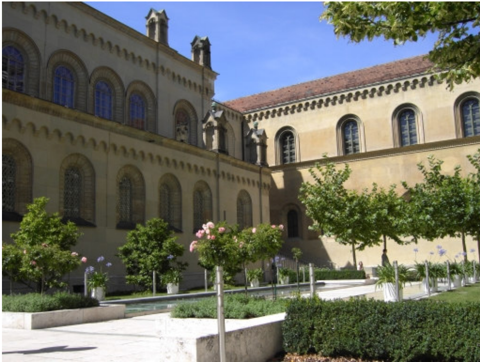
Mit der Öffnung des neu gestalteten Kabinettsgartens vor der Hofkirche im Juni 2003 wurde der Wiederaufbau der Residenz abgeschlossen.
