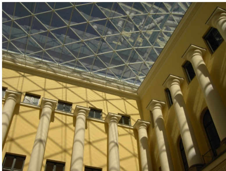
Innenhof des ehemaligen Odeons mit Glasdach
