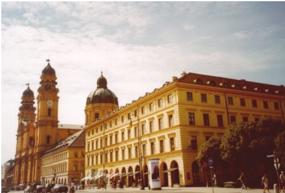
Blick auf das Anwesen Odeonsplatz 1 und das Palais Moy, welche die Einmündung der Brienner Straße flankieren, im Hintergrund die Theatinerkirche
