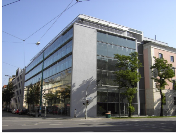
Das Eckgebäude nach seiner Fertigstellung (Foto: Susanne Rieger)
