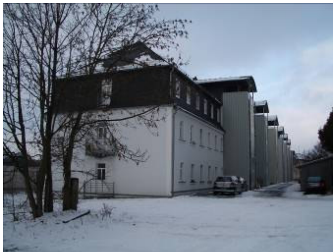
Abb. 24: Der Glashüttenweg heute, eine gelungene Sanierung
