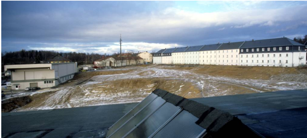
Abbildung 33: Blick auf die Fabrikhalle der AFEMA (links) und die Häuser des Glashüttenwegs (rechts)
