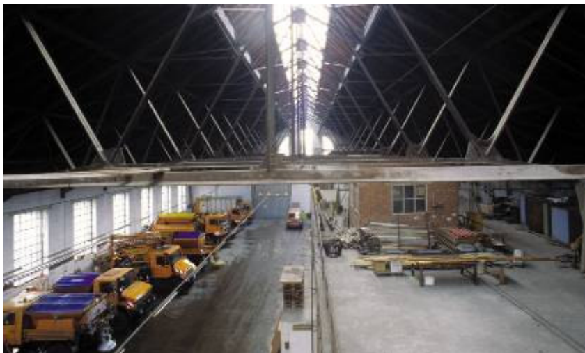
Abb. 31: Der Bauhof in der ehemaligen Schleif- und Polierhalle
