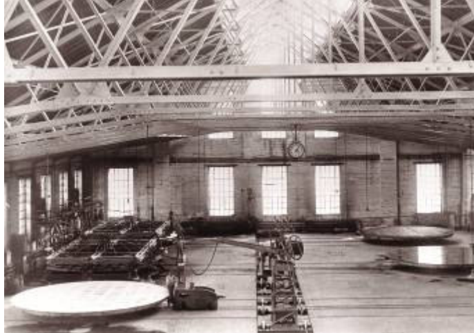
Abb. 14: Zwei Poliermaschinen (links hinten) mit einem Durchmesser von je 8 Meter; vorne links und hinten rechts sog. Wechseltische
