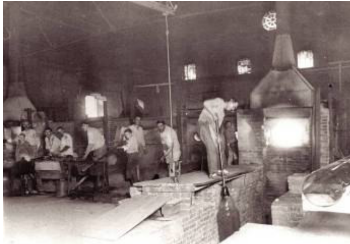
Abb. 2: Herstellen von Glaszylindern mit der Glasmacherpfeife in der Glashütte Marktredwitz um 1920
